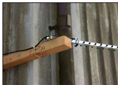
Exempel på alternativ montering av A300 utomhus för att undvika ett hinder
